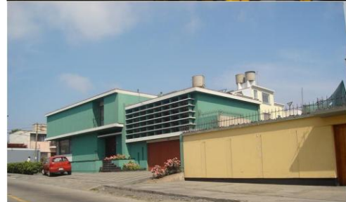
Edificaciones de los 60's con sistemas de protección solar en Lima.
